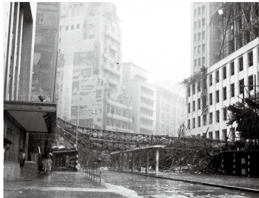
圖 7.14：德輔道中被塌下的棚架堵塞，道路被阻，未能行車。（圖片由岑智明先生提供）
