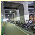
▲ 隧道或路軌下停車場。
